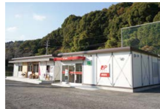
渡地区仮設店舗
