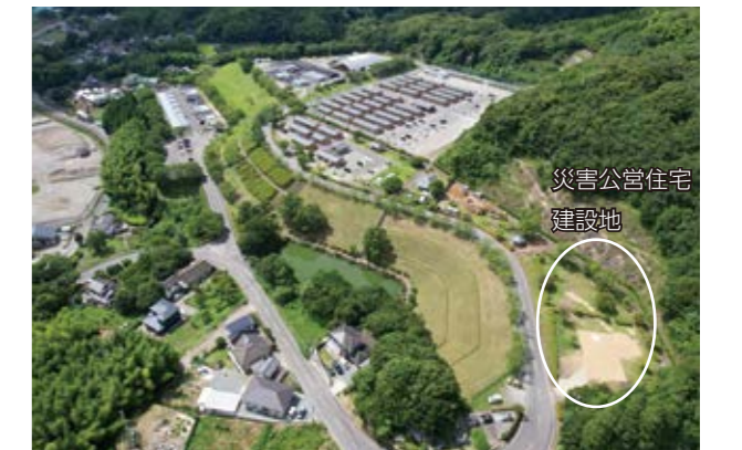
上空から見た渡地区の仮設住宅と災害公営住宅建設場所
