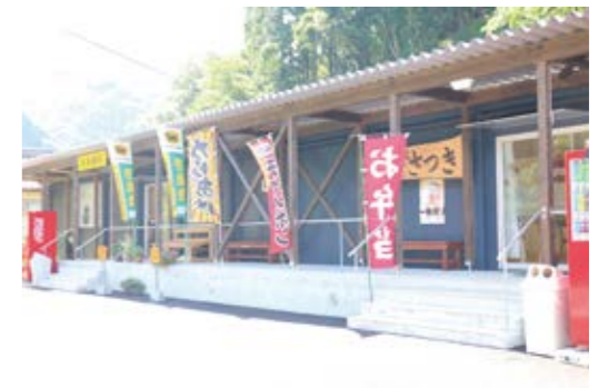
一勝地地区仮設店舗
