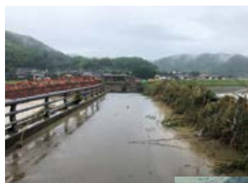
災害時の相良橋
