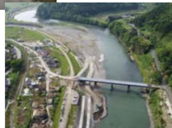
相良橋仮橋が完成した時の上空からの写真
