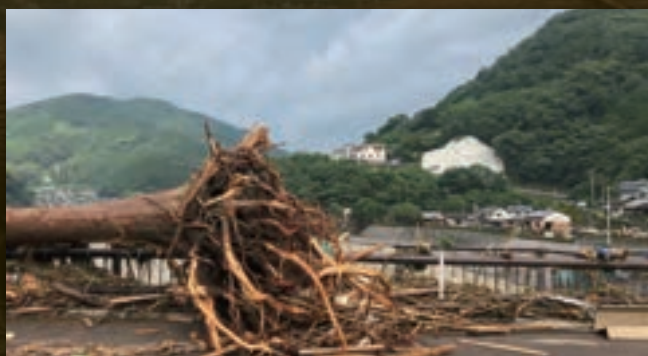
球磨橋被災の痕跡
