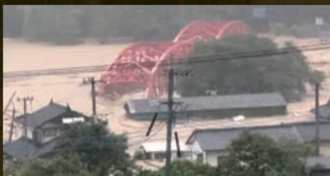
相良橋、流失前の様子
