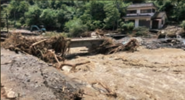
板崎地区被災状況
