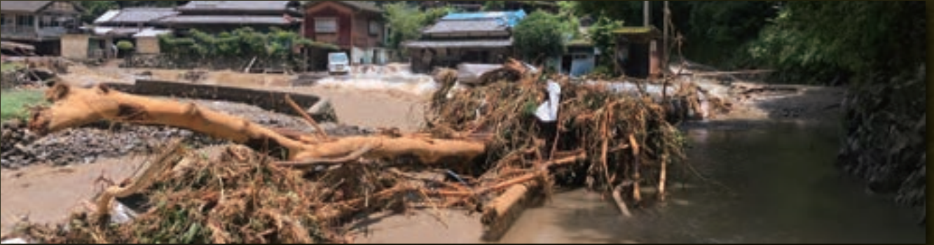
浦野地区被災状況
