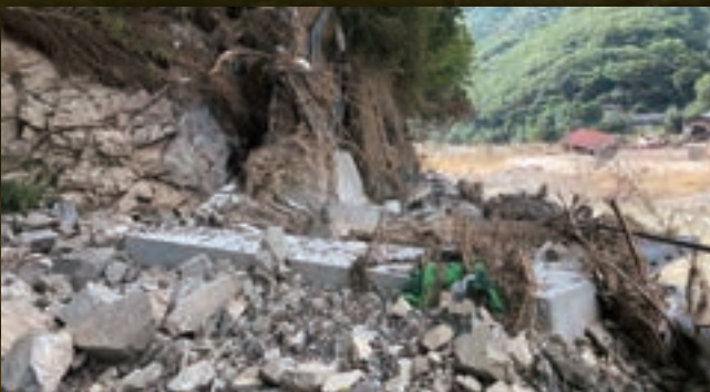
県道一勝地神瀬線被災状況
