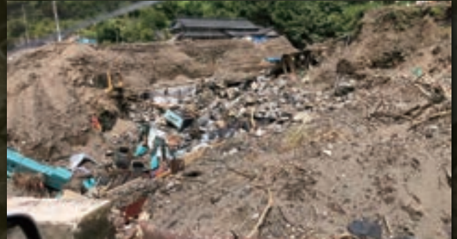
伊高瀬地区被災状況
