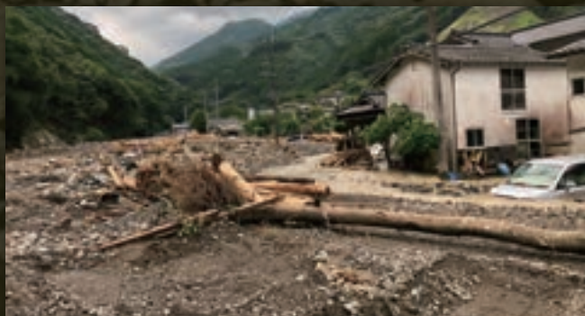
木屋角地区及び上原地区被災状況
