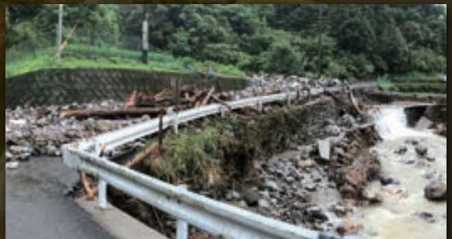
村道沢見線被災状況
