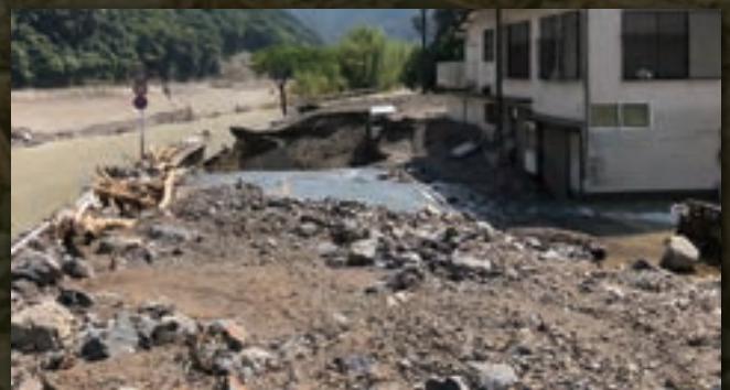
国道219号多武除地区被災状況
