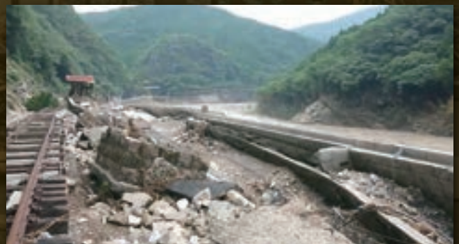
JR肥薩線球泉洞駅付近被災状況
