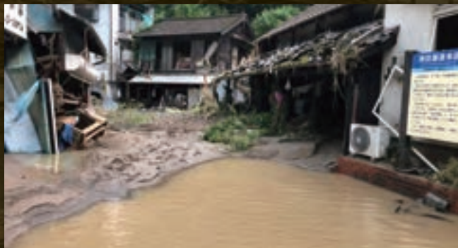
湊田酒造付近被災状況
