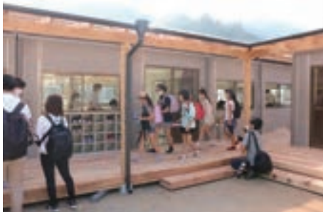
渡小学校コンテナハウス
