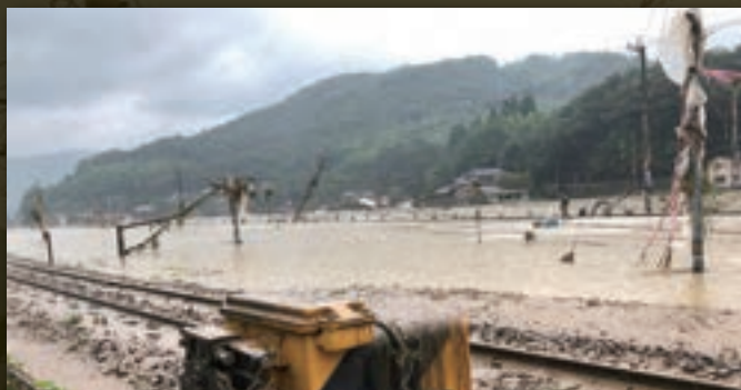
地下の踏切から、標識が倒れ電柱が傾く様子
