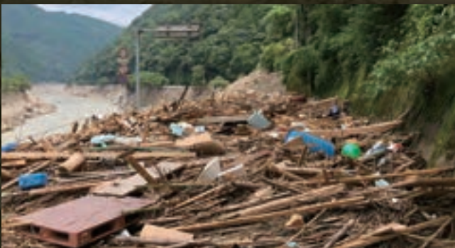
国道219号線瀬戸石付近被災状況
