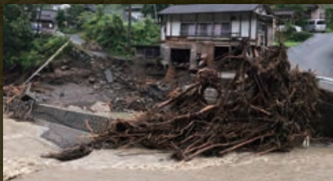
糸原地区、糸原橋の流失状況
