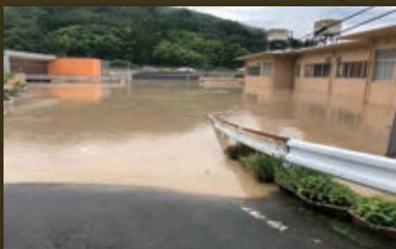
福祉施設及び渡小学校の浸水状況
