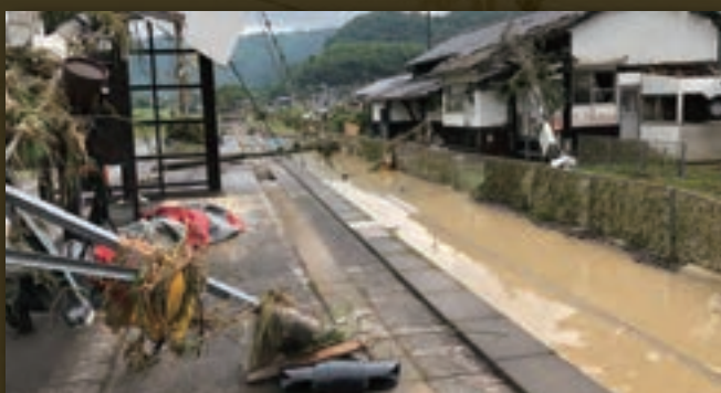
JR肥薩線渡駅被災状況
