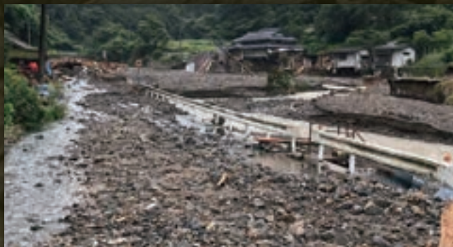
松野地区被災状況
