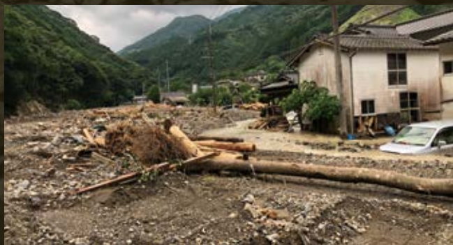
木屋角地区及び上原地区被災状況
