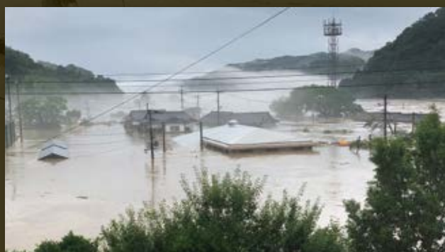
指定緊急避難場所であった渡多目的集会施設の発災時の浸水状況
