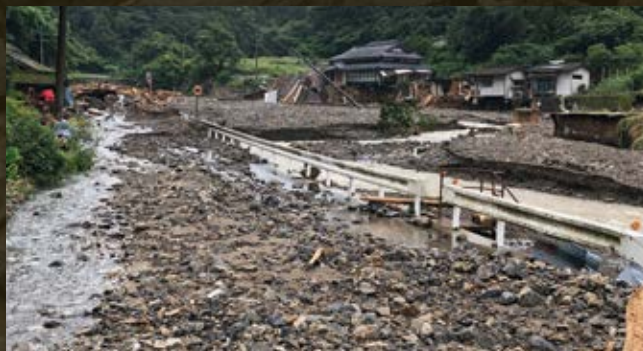
松野地区被災状況
