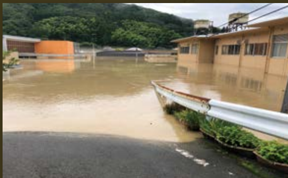
福祉施設及び渡小学校の浸水状況
