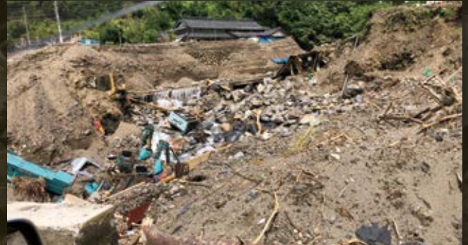
伊高瀬地区被災状況
