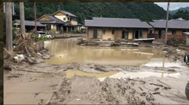
木屋角地区被災状況
