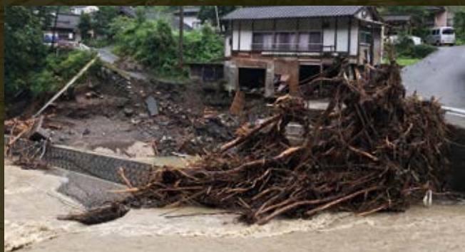
糸原地区、糸原橋の流失状況
