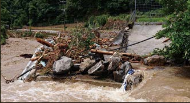
四蔵地区被災状況
