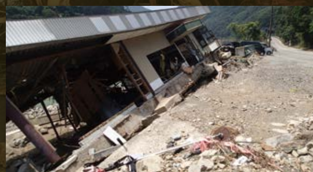
小谷地区被災状況
