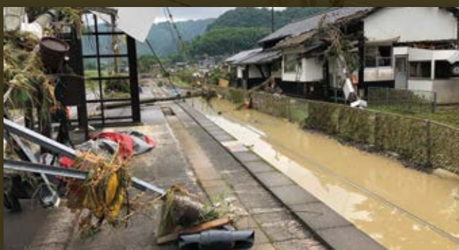
JR肥薩線渡駅被災状況
