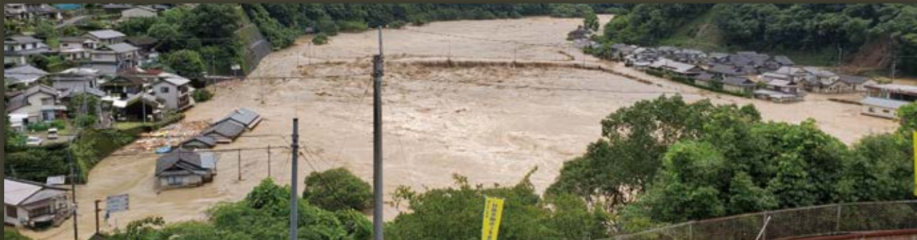
友尻地区及び中園地区の被災状況
