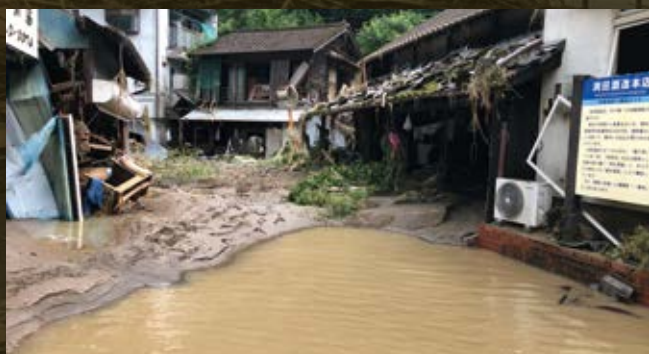
湊田酒造付近被災状況
