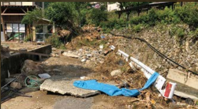
県道高沢一勝地線被災状況
