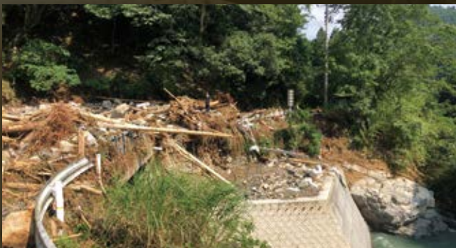
坂口地区被災状況
