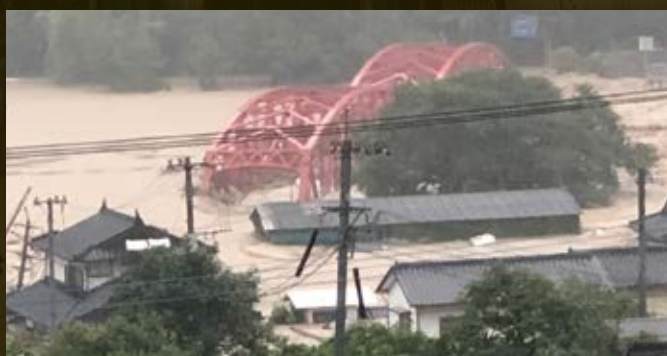
相良橋、流出前の様子
