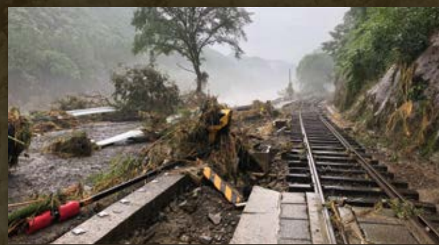
JR肥薩線那良口踏切被災状況
