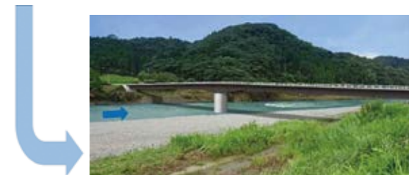
橋梁形式：鋼2径間連続鋼床版桁橋
