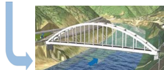
橋梁形式：鋼単純アーチ橋
