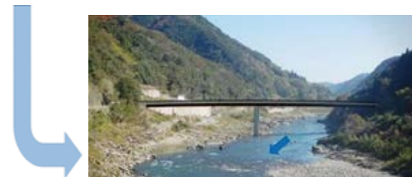
橋梁形式：鋼2径間連続鋼床版桁橋
