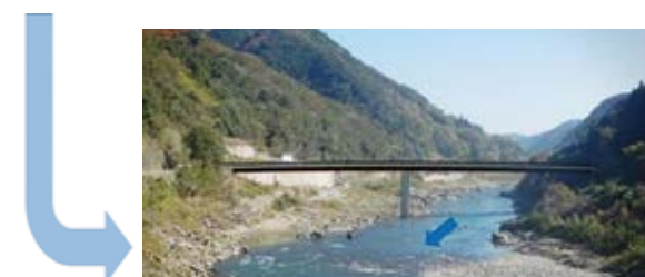
橋梁形式：鋼2径間連続鋼床版桁橋
