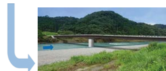
橋梁形式：鋼2径間連続鋼床版桁橋
