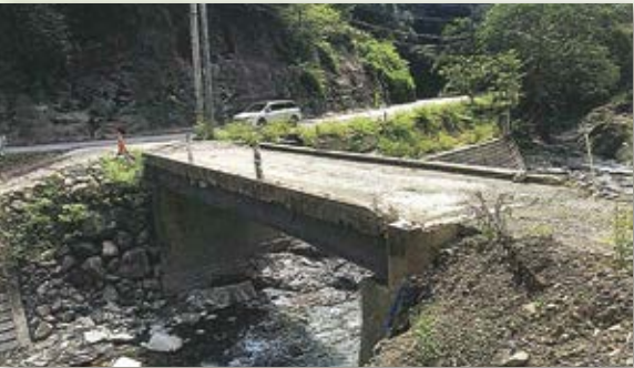
【板崎班】地区内橋梁塗装作業
