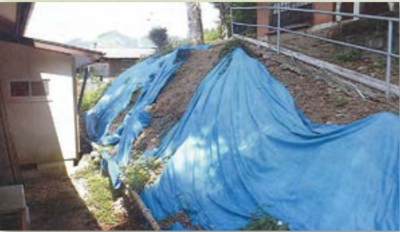
【小川班】安全対策整備
