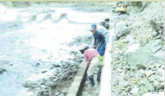
【立野班】用水路消防水利の整備、修繕
