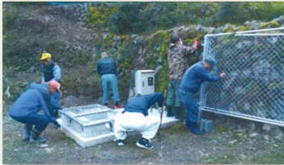
【立野班】フェンス取付作業
