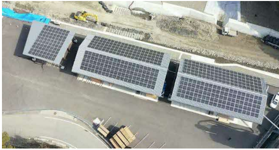
木質バイオマス施設の太陽光発電設備 (令和4年度施工、左：太陽光パネル、右：蓄電池)
