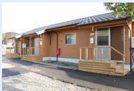
▲ 芝生広場木造仮設住宅
