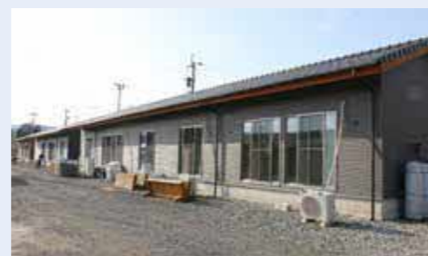
▲ グラウンド内木造仮設住宅整備の様子（3月19日時点）
