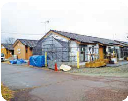
村有住宅へ改修中の仮設住宅
