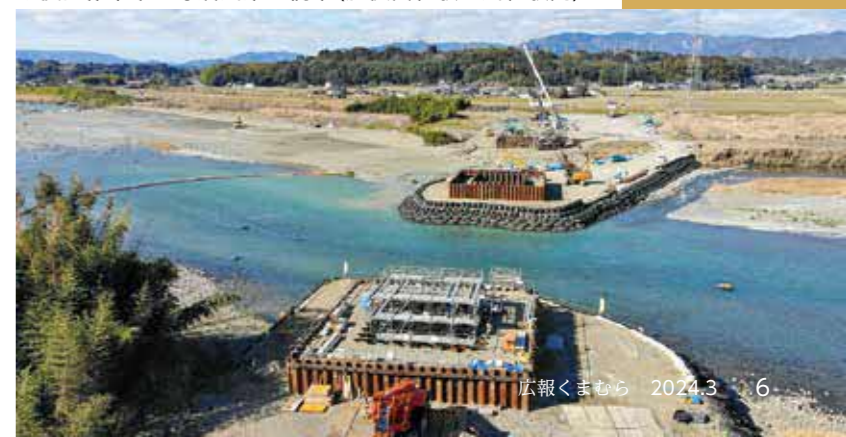
▼復旧作業中の球磨川第四橋梁(肥後西村駅～川村駅間)
