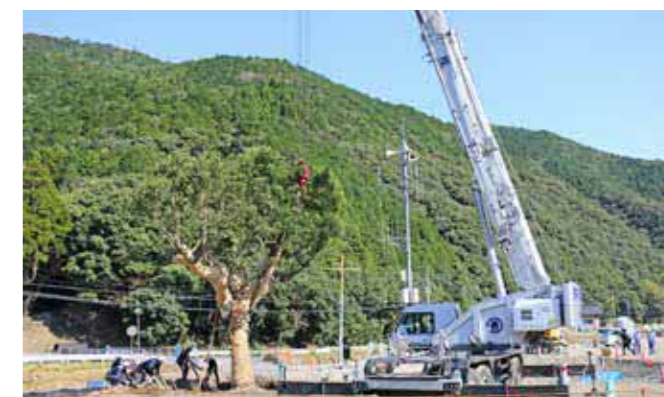
クレーンで吊り上げて移植しました
