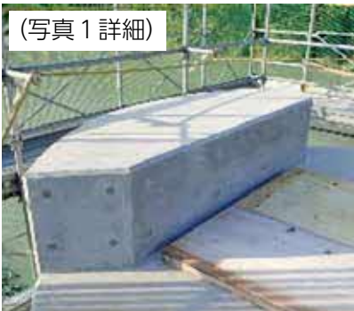
支点部を守るコンクリートブロック
