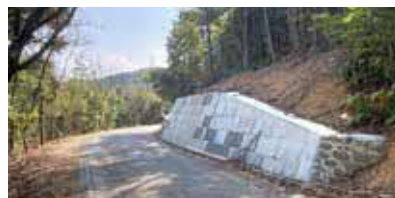
村道蔵谷沢見線（完了）
