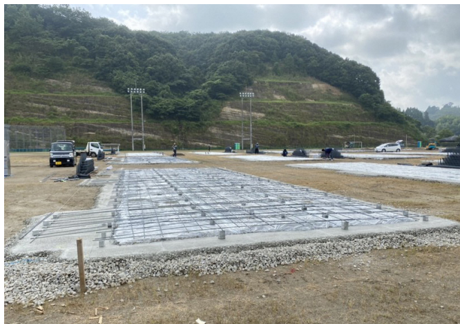
(仮称) 球磨村グラウンド仮設団地の工事様子 8月8日撮影
