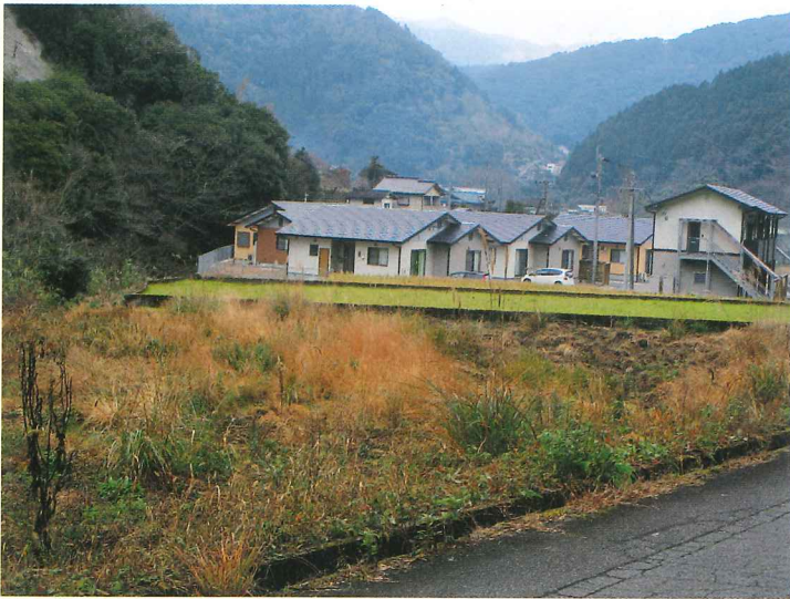
増設予定の一勝地永崎団地
