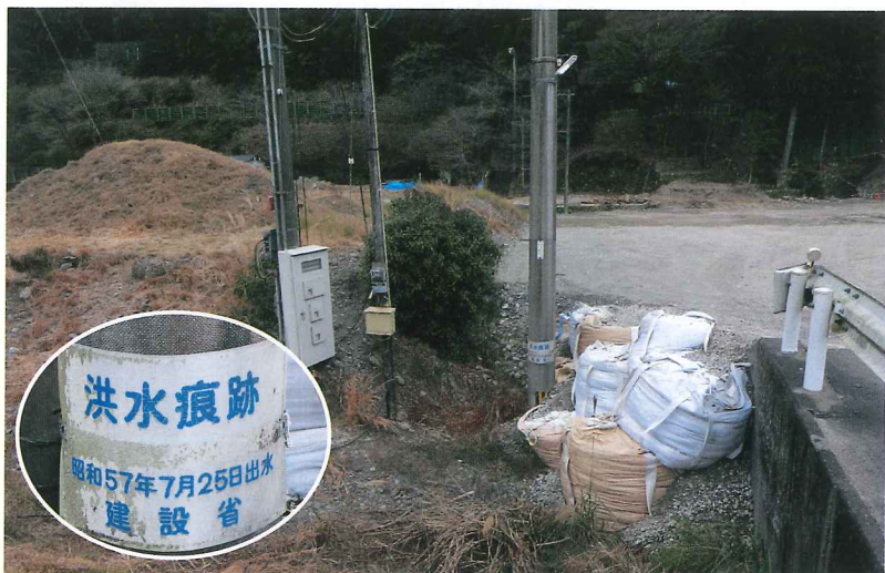
神瀬防災広場報造成地
