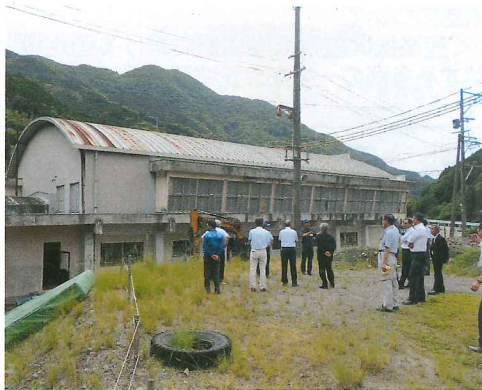
解体される旧神瀬小体育館
