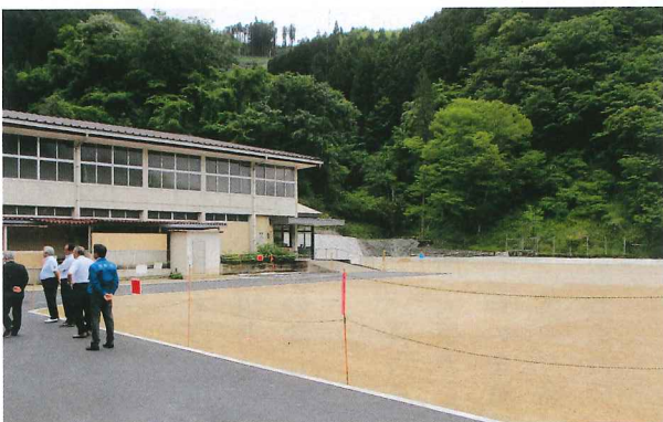
整備された高沢避難所防災広場（ヘリポート）
