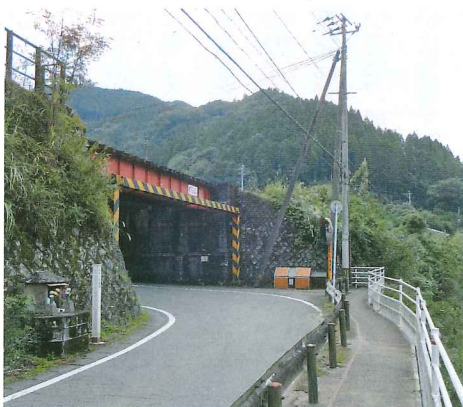
冠水し通行止めとなるガードしたの道路
