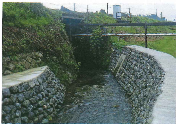
継続される峯川河川整備工事
