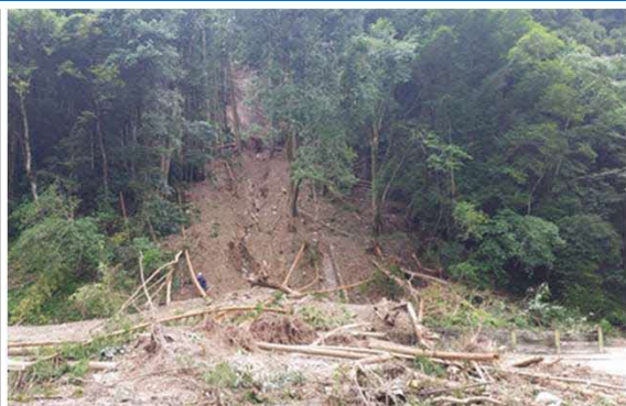
⑧ 友尻 山腹工着工前
